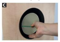
Wird der Niedervoltstecker gezogen, kann alternativ das ganze EPP-Gehäuse inkl. Ventilator entnommen werden.
